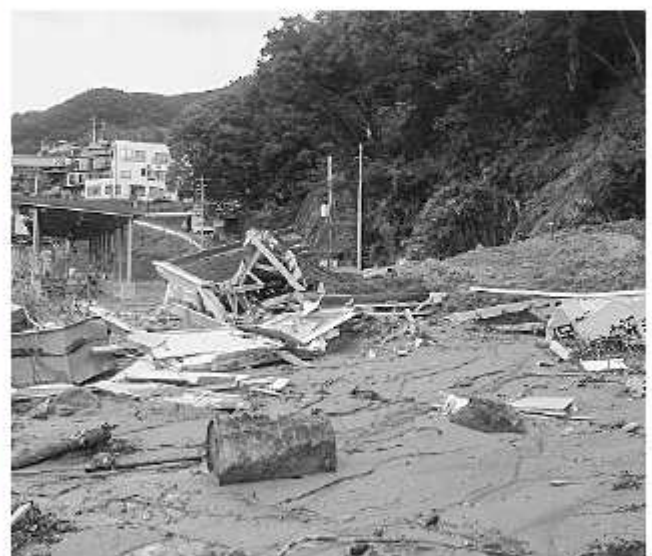
吉浜・根白漁港の土砂崩れ
