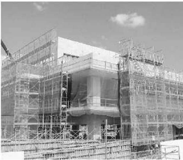
市公共工事現場
