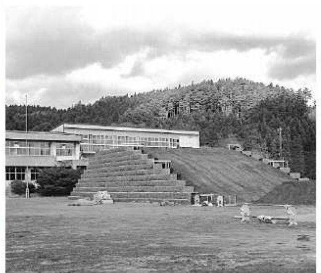
旧甫嶺小のBMX施設造成工事
