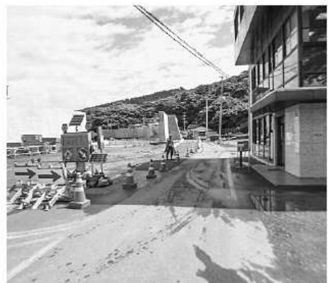
工事中の市道
