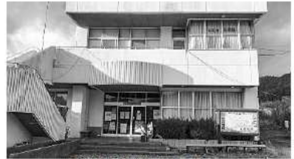
防災学習館(漁村センター) 防災学習ネットワーク構築整備事業費等 5,000万円
