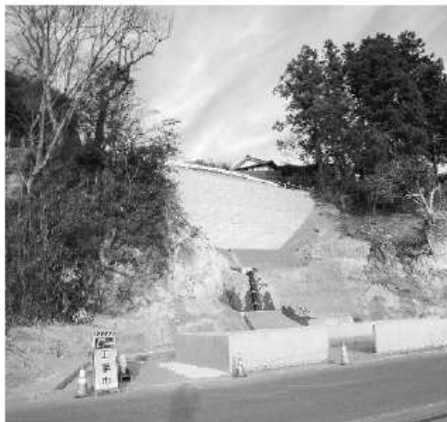
根白漁港の土砂災害復旧の様子
