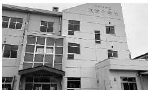
末崎中学校各教室等に冷房(エアコン)を設置
