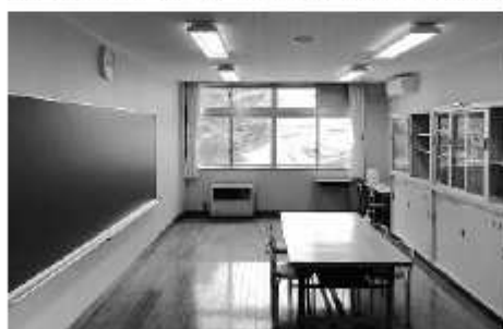
特別支援教室の内装設備を改修
