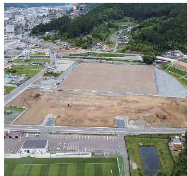
地元業者による建設工事
