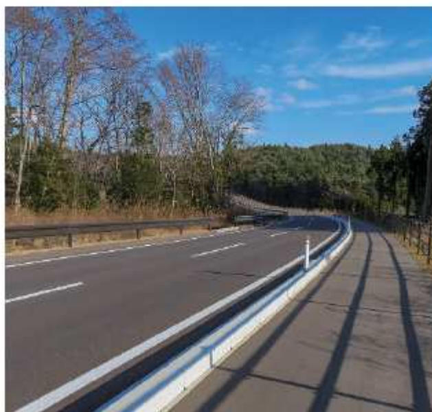
新設された県道碁石海岸線
