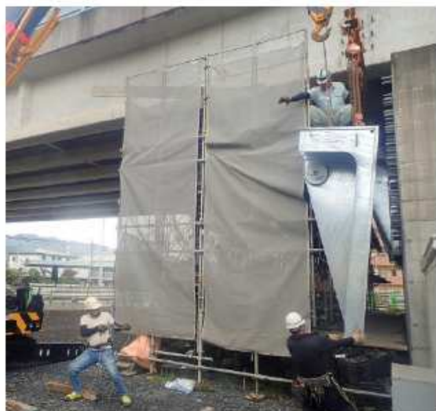
市発注の工事風景
