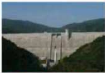
工事開始から18年の歳月をかけて 完成した鷹生ダム
