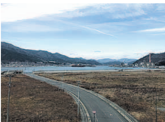
I-LC物流ハブとして期待される永浜・山口地区岸壁
