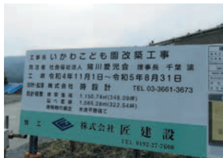
改築される園舎工事 2億1,240万円
