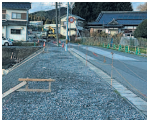
市が発注した舗装工事の様子
