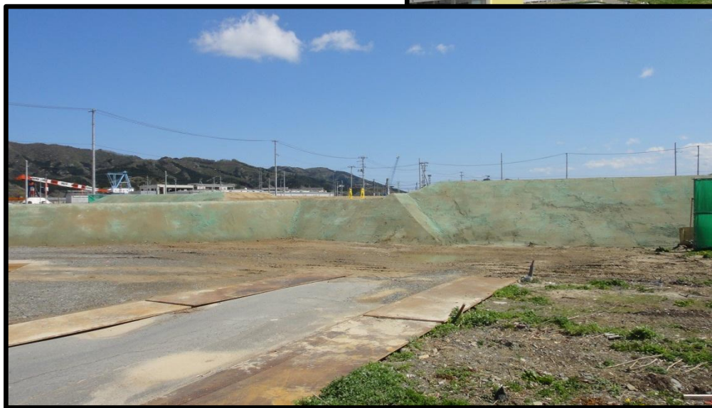
津波復興拠点(先行区域)の盛土状況
