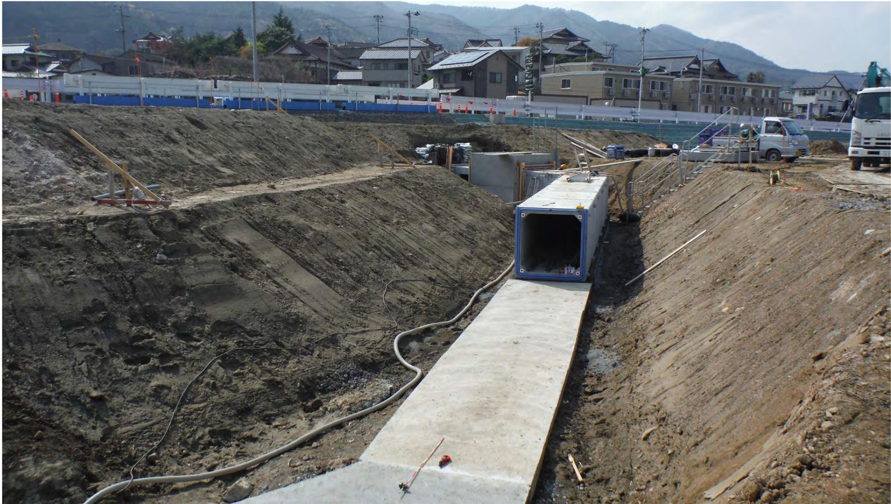
新県道北側、盛土前のインフラ構築。ボックスカルバート排水路の施工状況。
