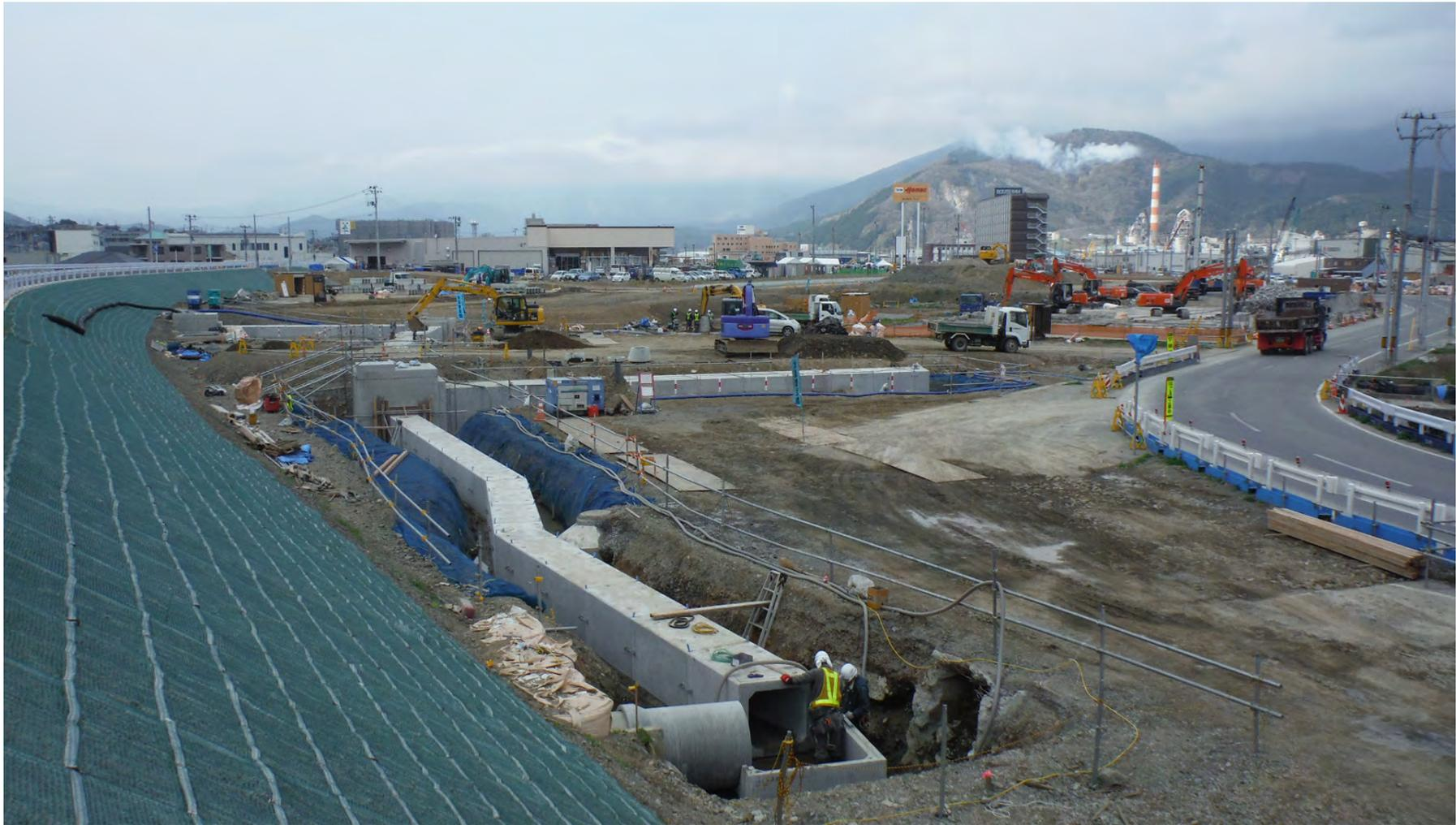
新県道南側のボックスカルバート排水路の施工状況。平成28年4月
