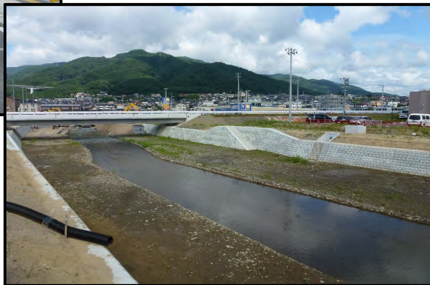
須崎川護岸工事（岩手県河川工事）
