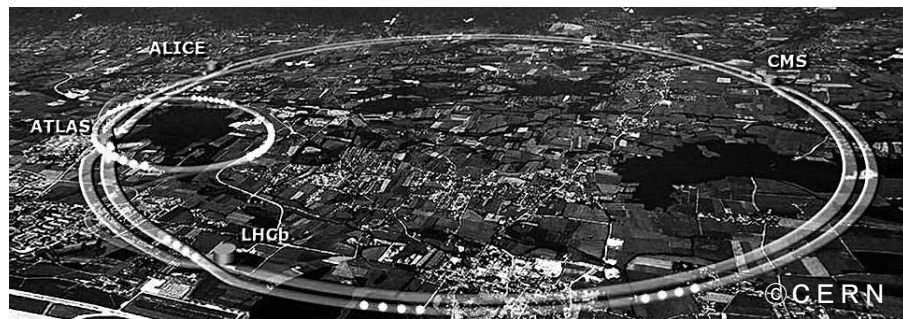
CERN施設のある街の様子
