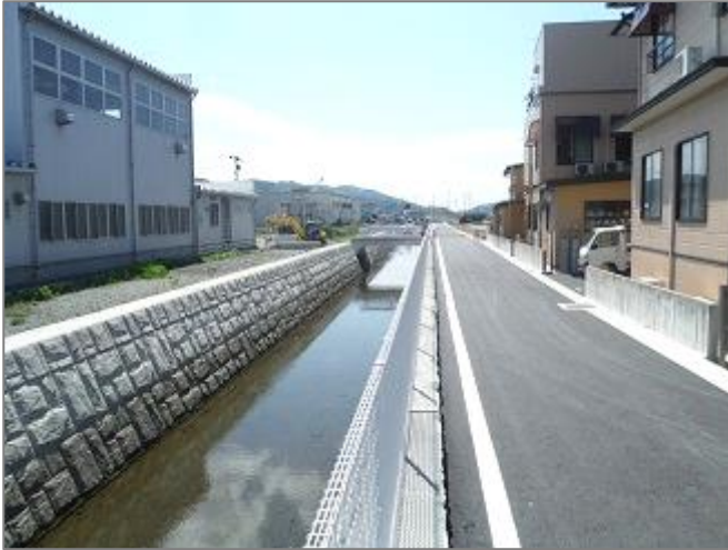
1 地ノ森地区 内水排水対策事業（No.1）施工中
