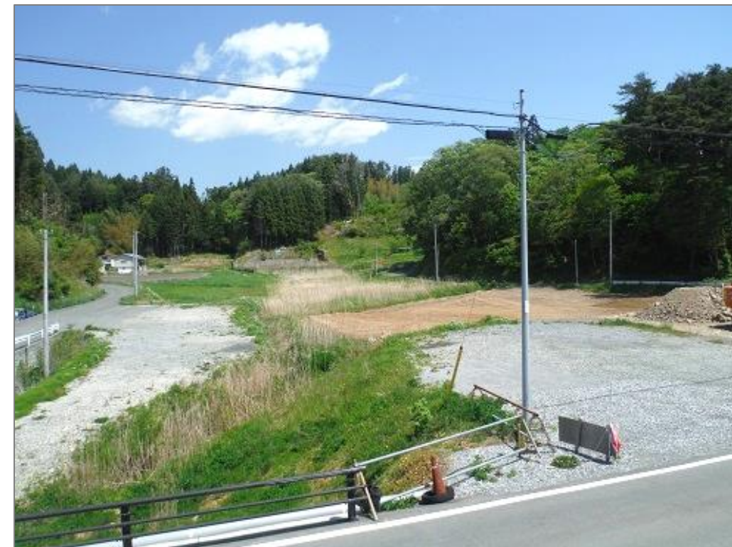
4 泊里・碁石地区 浜の暮らし体験ゾーン・駐車場の整備（No.13）施工中
