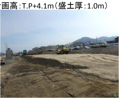
・新県道（平成28年3月現在施工中）（北東から見る） 計画高:T.P+4.1m(盛土厚:1.0m)
