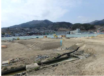
・新県道（平成28年3月現在施工中）（北東から見る） 計画高:T.P+2.3m(盛土厚:1.8m)
