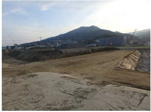
・津波拠点（平成28年3月現在施工中） （北東から見る） 計画高:T.P+2.9m(盛土厚:2.0m)
