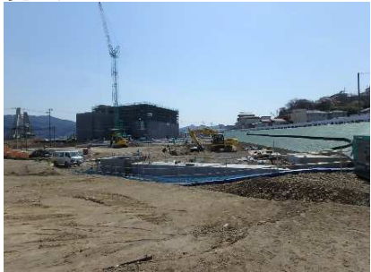
・新県道（平成28年3月現在施工中）（北から見る）
