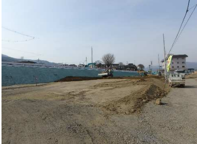
・区8-2号線（平成28年3月現在施工中） （南東から見る） 計画高:T.P+3.0m(盛土厚:1.0m)
