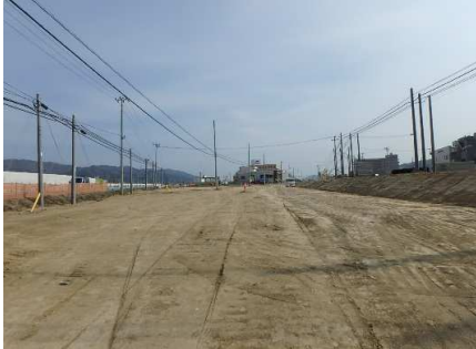
・新県道（平成28年3月現在施工中） （北東から見る） 計画高:T.P+2.0m(盛土厚:1.5m)
