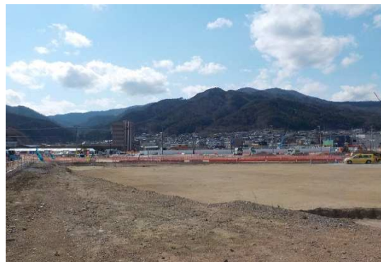
・新県道（東から見る）
