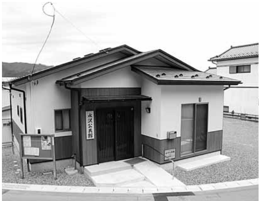
復旧が完了した地域公民館(大船渡町永沢)
