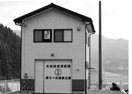
復旧が完了した消防屯所 (三陸町越喜来泊地区)
