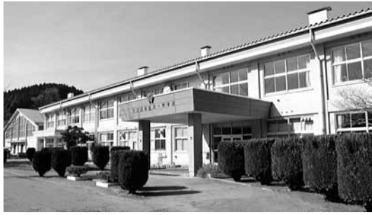
第一中学校の校舎・屋内運動場の改築に着手
