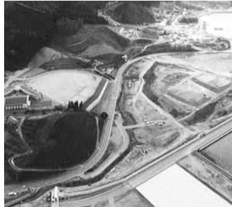
道路整備が進む山口地区
