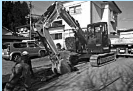
下水道管きょ工事や舗装本復旧工事などを行いました
