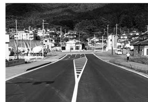
【市道田茂山佐野線舗装修繕工事】
