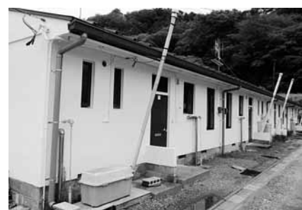
【改修が進む長安寺団地】
