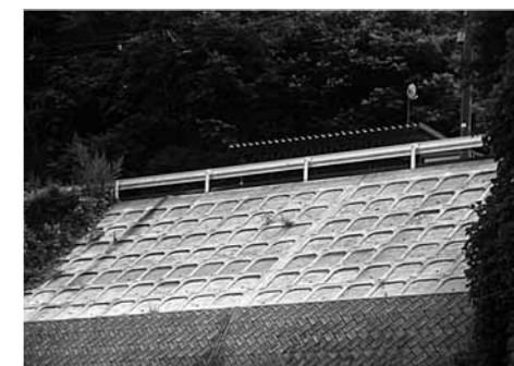
【市道笹崎下船渡線法面修繕工事】
