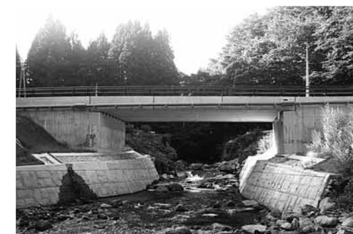
【桃の木渡橋橋梁修繕工事】
