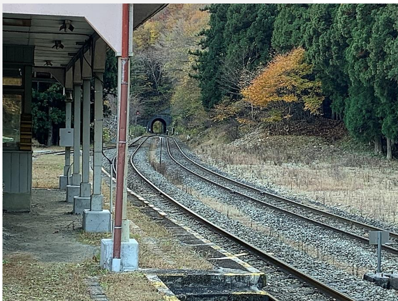
関谷の旧駅舎からみるトンネル
