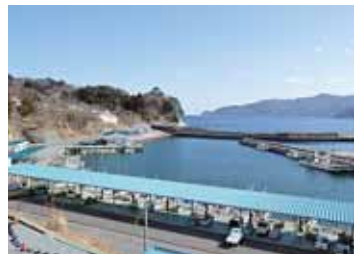
復旧した根白漁港荷捌き場
