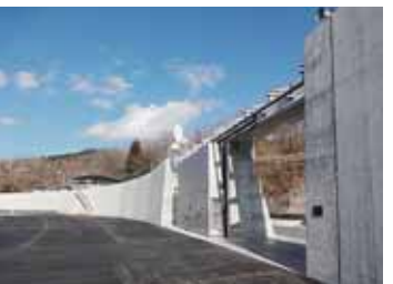
防潮堤を整備
