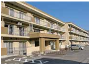
災害公営住宅(下欠東アパート)
