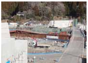
完成に向け進む防潮堤工事
