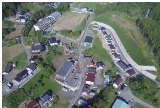
■蛸ノ浦地区の防災集団移転団地
