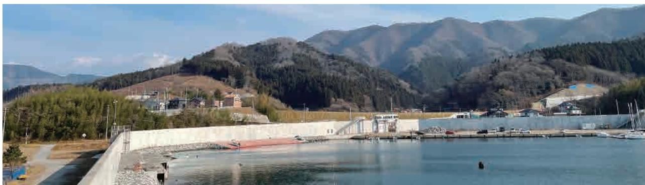
■防潮堤が整備された永浜地域
