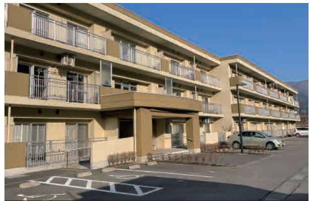
■災害公営住宅 下欠東アパート
