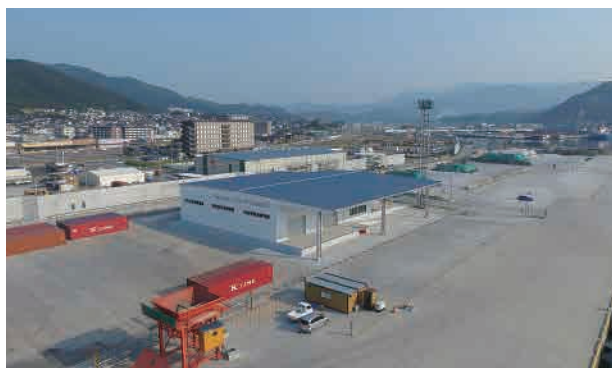
■大船渡港国際コンテナターミナル
