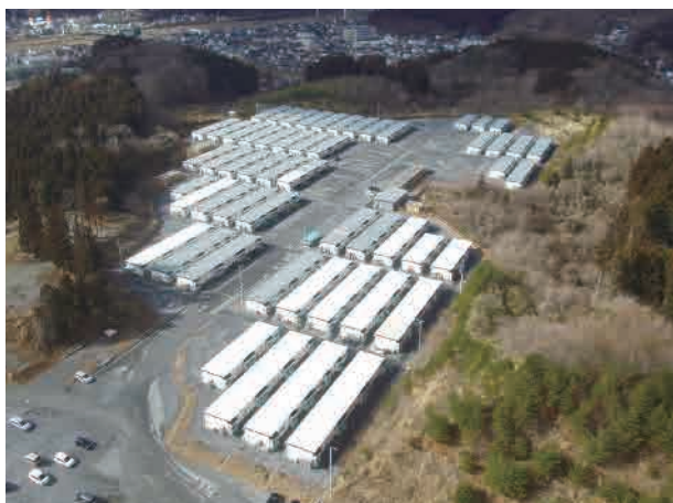
■市内最大規模の長洞仮設団地
