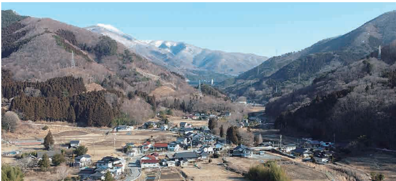
■鷹生ダムを望む集落
