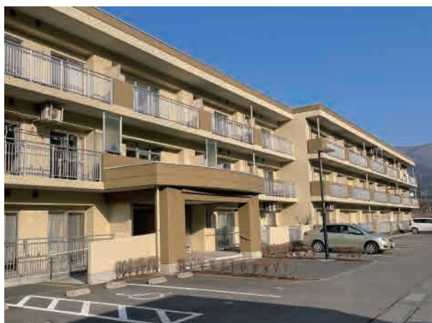
■災害公営住宅 下欠東アパート
