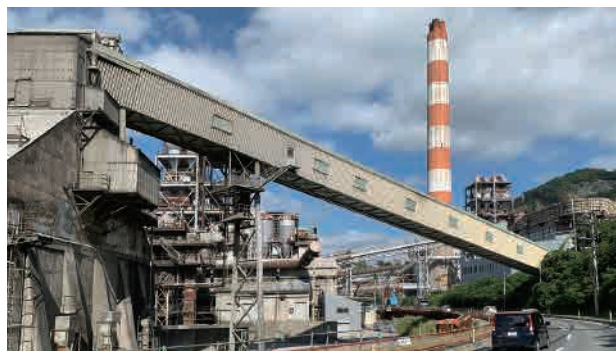
■ 早期に再建稼働した工場
