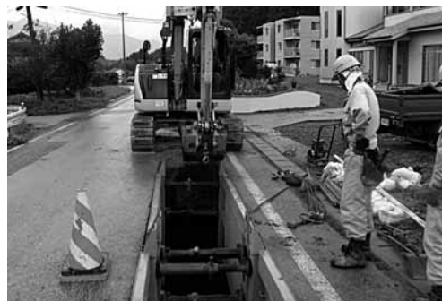
市内を進む下水道工事
