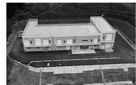
日頃市町、立根町の給水地域の拡大【第4浄水場】
