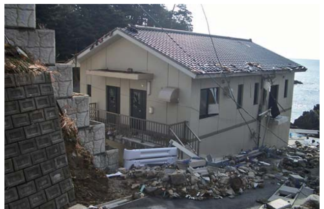
千歳地区漁業集落排水施設
