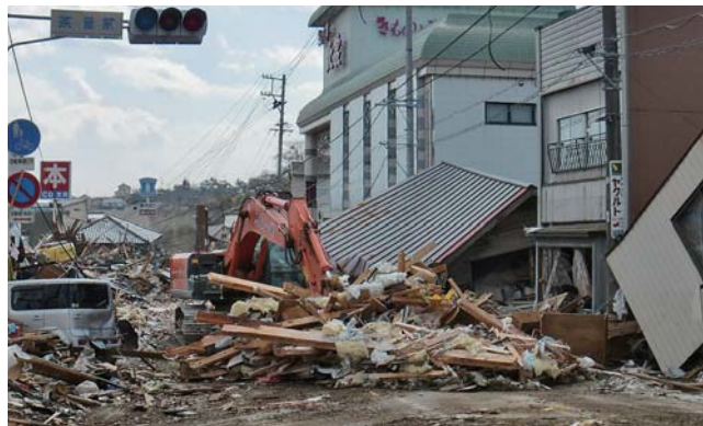
国道45号の道路啓開作業
