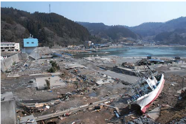
綾里漁港付近
