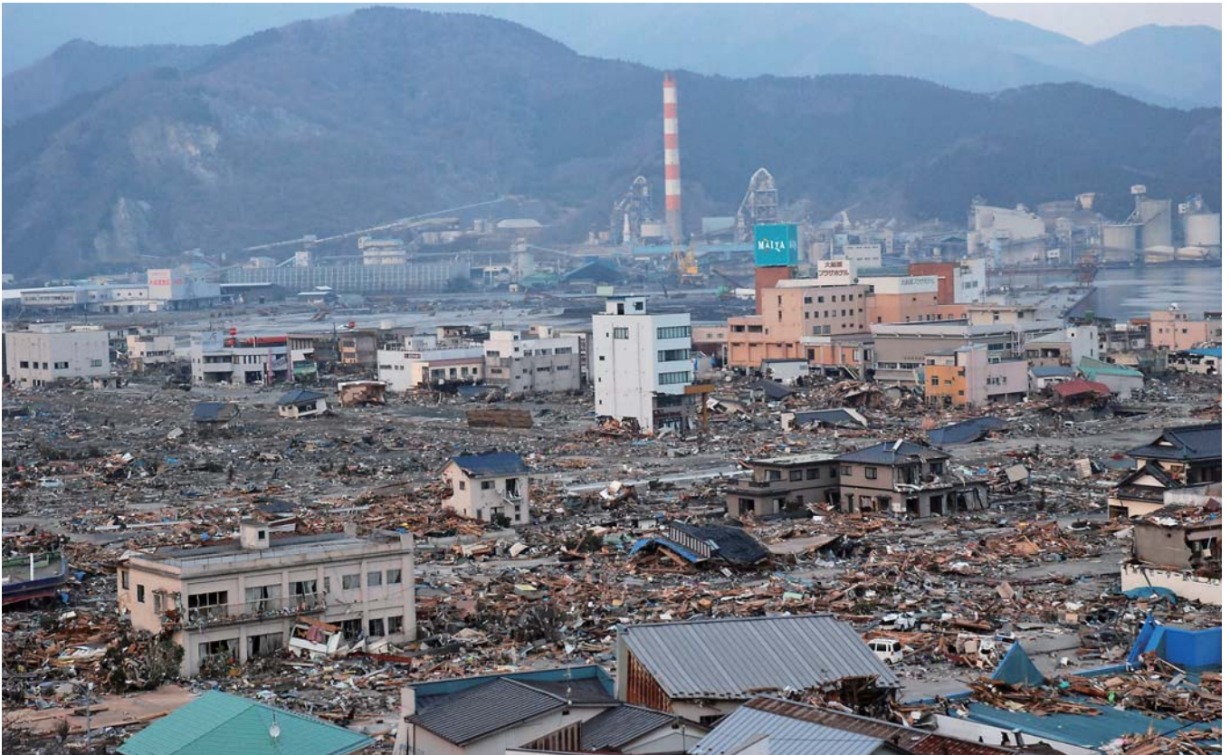
甚大な被害が発生した中心市街地
