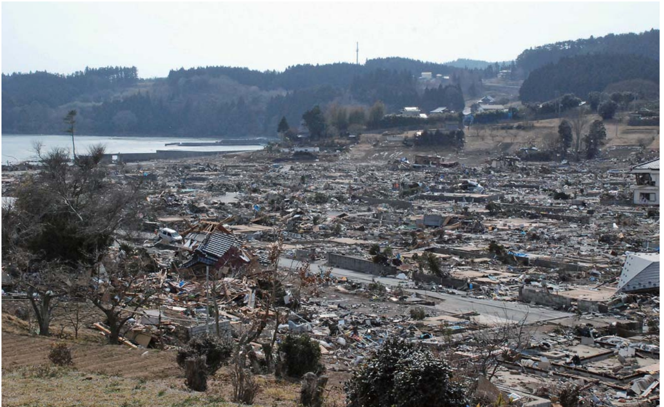
多くの家屋が流失した大田団地
