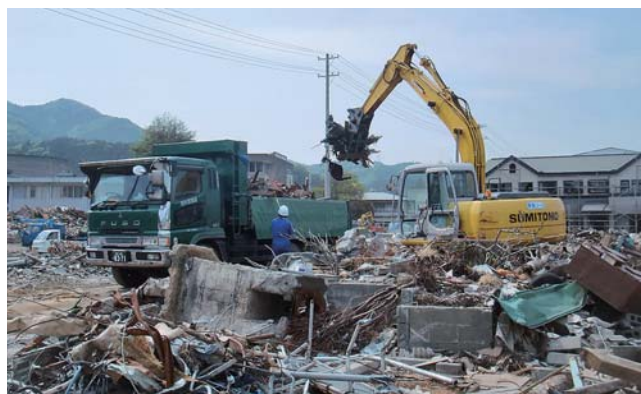
がれき撤去作業②
