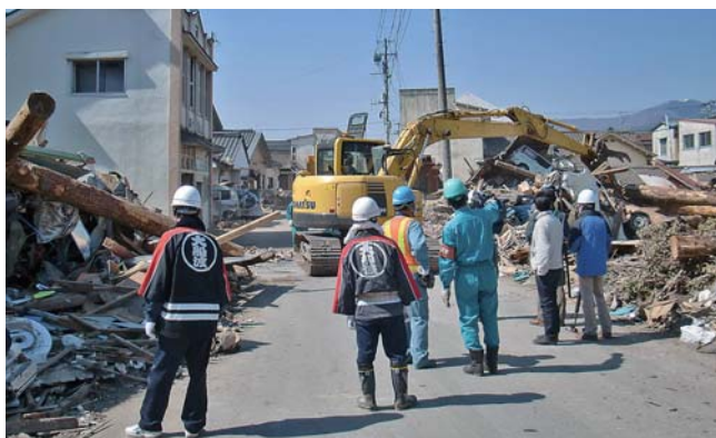
がれき撤去作業①
