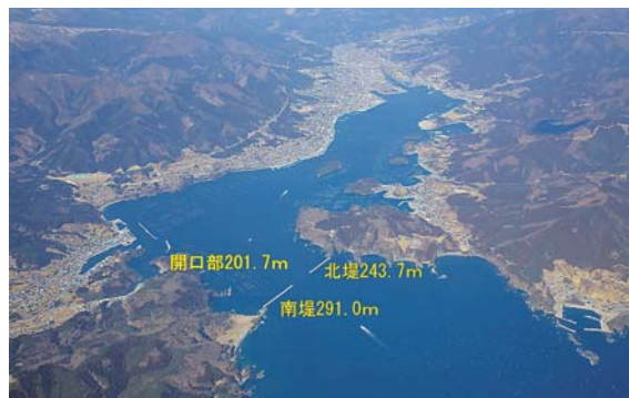
上空から見た湾口防波堤（写真：釜石港湾事務所）
