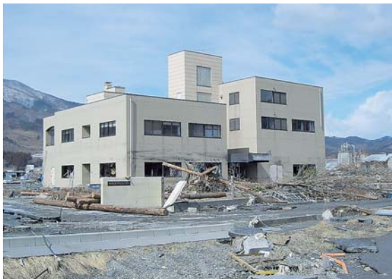
被災した大船渡浄化センター
