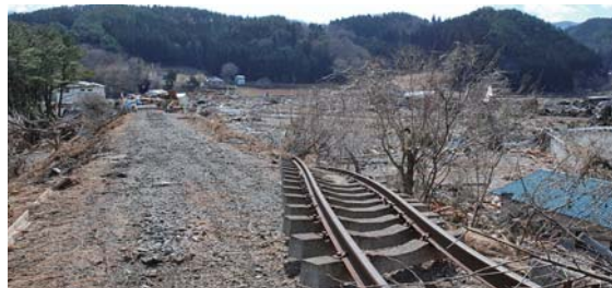
津波により流失した三陸鉄道の線路
