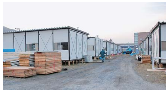
建設中の応急仮設住宅
