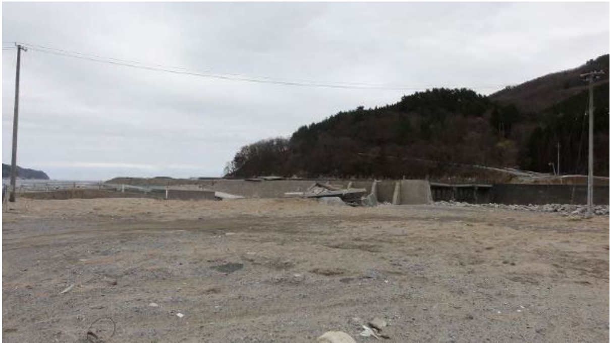
【整備前の被災状況】
