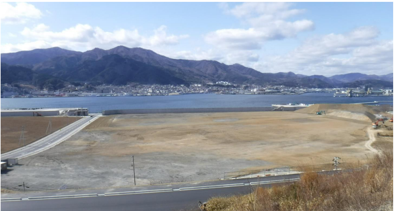
【仮置き場全景（完了後）】
