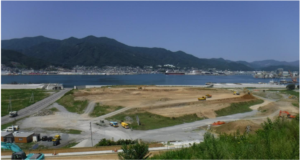
【仮置き場全景（着工前）】
