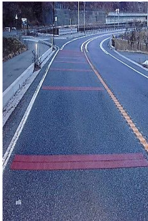
(写真1 薄層舗装)
