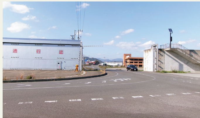
市内各所に防潮堤や陸閘を整備
