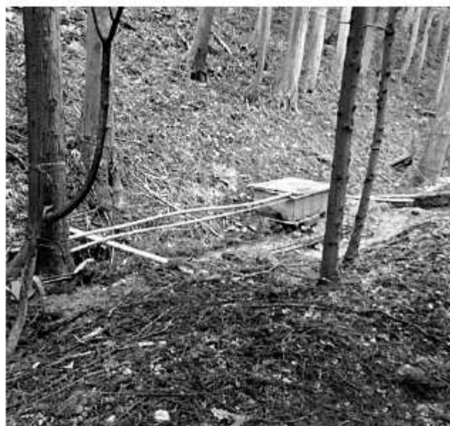
未給水地域の第一貯水タンク
