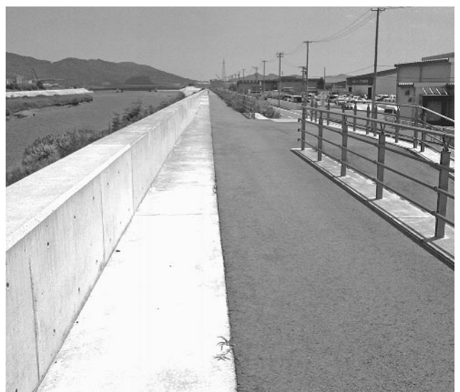
盛川右岸の嵩上げ状況
