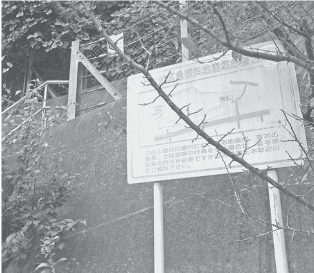
急傾斜地崩壊危険区域の看板
