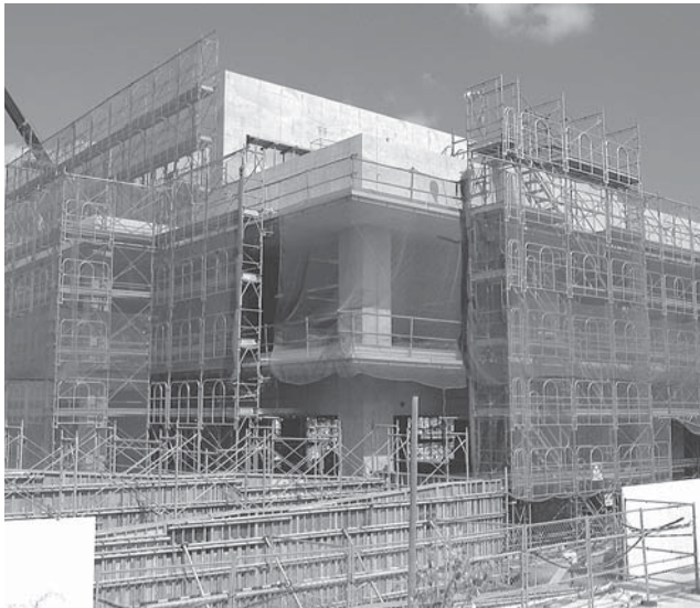
工事が進む津波防災拠点施設
