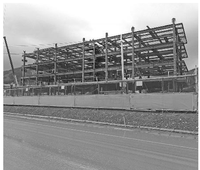
津波復興拠点での建設中の様子
