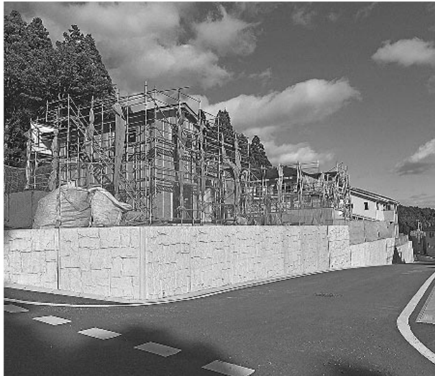
建設中の高台移転住宅
