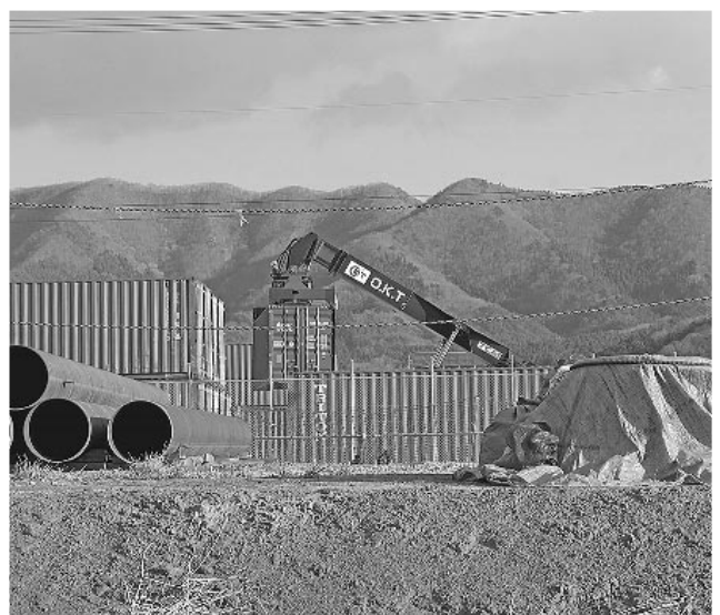
場内でのコンテナ運搬中の様子
