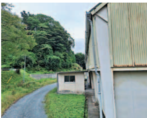
盛小体育館は急傾斜地崩壊区域内に立地
