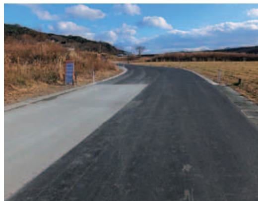
最近完成した市道
