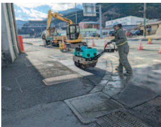
市内公共工事の現場
