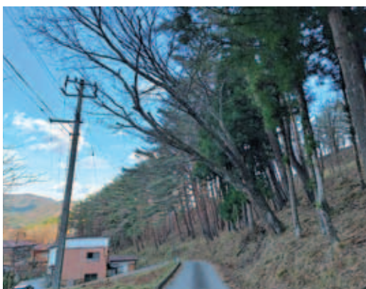
樹木等の崩落の危険が指摘されている
