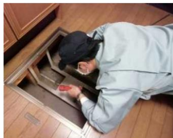
「土台・床組、基礎」調査の様子
