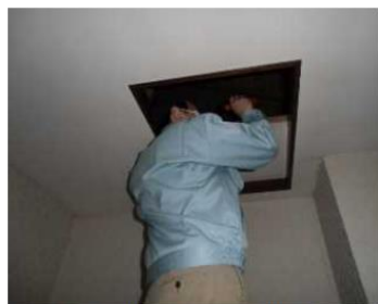
「小屋組・梁」調査の様子
