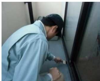
「外部（バルコニー）」調査の様子
