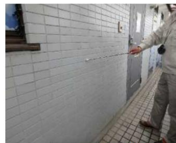
「外部（外壁）」調査の様子
