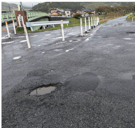
道路陥没の修繕か所
