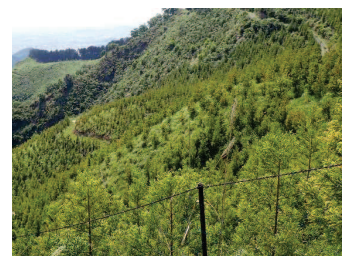
復旧後の状況
