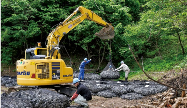
県による治山・砂防応急工事
