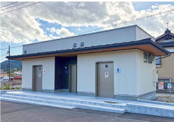
防災公園トイレ
