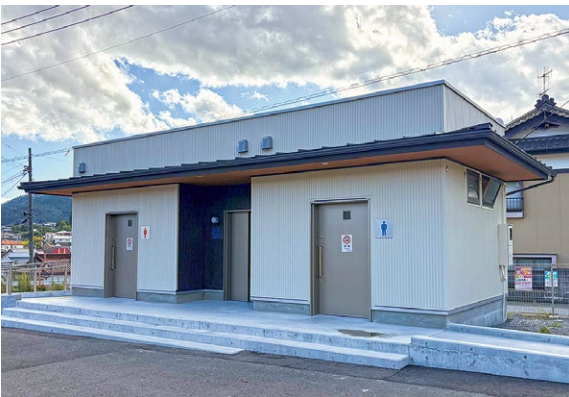
防災公園トイレ
