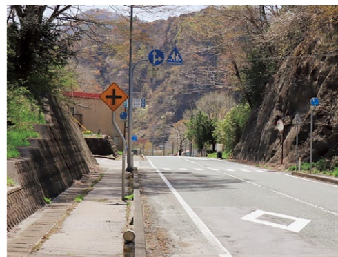
木下さんが見守りをする横断歩道。歩行者が見えづらい危険ポイント（日頃市町関谷地内、④盛方面・⑤世田方面から撮影）
