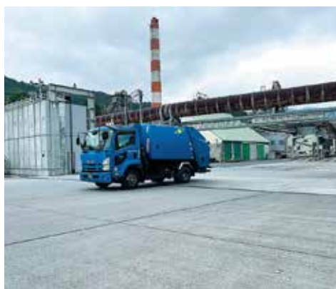
市内の民間事業所構内のコンクリート舗装道路
