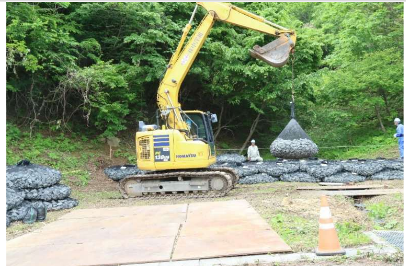
大型土のう設置
