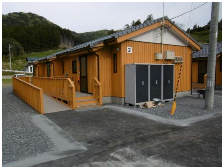
建設型応急仮設住宅(蛸ノ浦地区)
